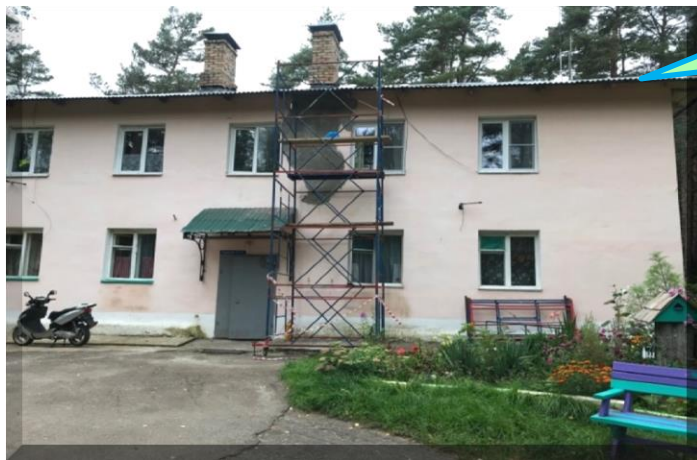
Установка лесов для выполнения работ по ремонту
